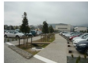
Noue à l'échelle d'un parking
