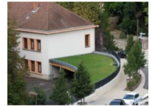
Toiture végétalisée à l'échelle d'un bâtiment
