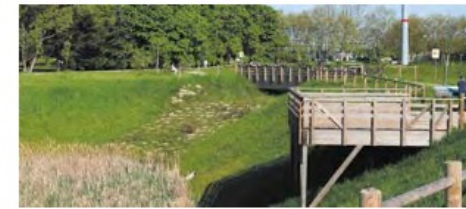
Bassin d'infiltration à l'échelle d'un espace vert
