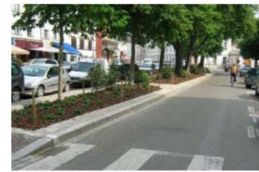
Tranchée filtrante à l'échelle d'une voirie
