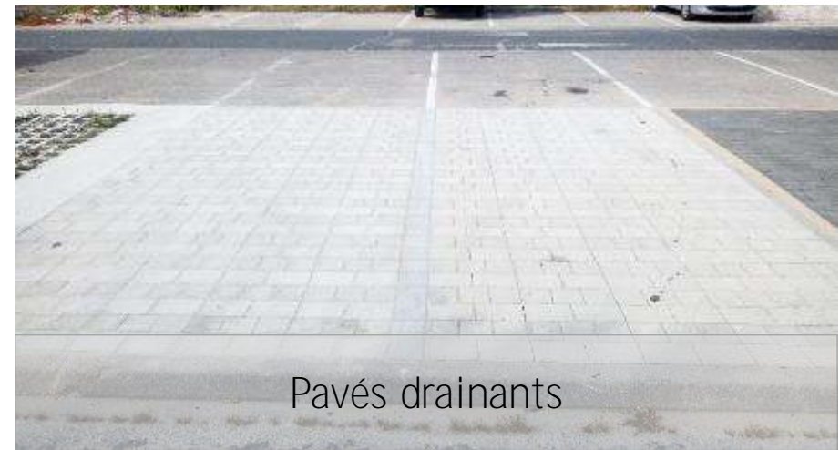
Pavés à joints poreux (pavés munis d'écarteurs)
