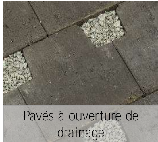
Pavés à joints poreux (pavés munis d'écarteurs)
