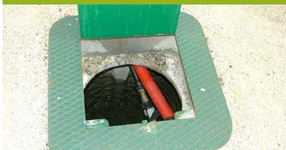
Trappe d'accès à la cuve enterrée de récupération d'eau de pluie des serres municipales (source : Mérignac)
