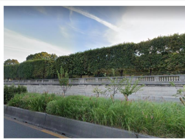
Séparateurs végétal en bord de voirie
