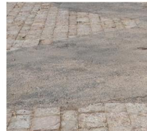
Enrobé bitumineux beige / gris recouvrant les travaux de réseaux
