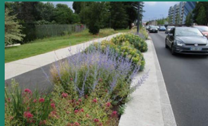
Mise en œuvre d'une bande « passe-pied » entre le massif planté et la route. L'entretien est simplifié (diminution des risques d'accident), les végétaux sont éloignés de la voirie, les bordures mieux scellés.
