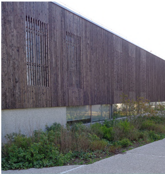
Aménagement arbustif géré en espace « lieu de vie » avec conduite libre des arbustes. / Nicolas Abbe, Orléans Métropole
