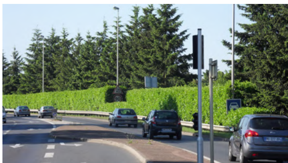
Aménagement imposant qui nécessite un entretien lourd, coûteux et impactant pour la circulation des véhicules./ Pierre Héry
