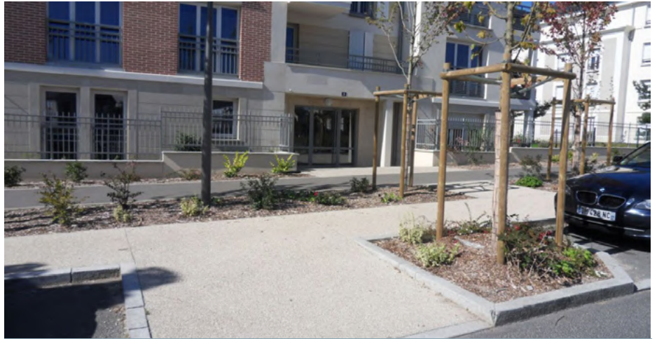
Le cheminement naturel entre le passage piéton et l'accès à la résidence passe à travers le massif planté. Le risque de piétinement est donc important. Il aurait été préférable d'anticiper cette situation en décalant le passage piéton ou le passage à travers le massif./Pierre Héry
