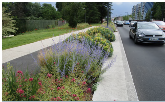
Mise en œuvre d'une bande « passe-pied » entre le massif planté et la route. L'entretien est simplifié (diminution des risques d'accident), les végétaux sont éloignés de la voirie, les bordures mieux scellées./ Pierre Héry
