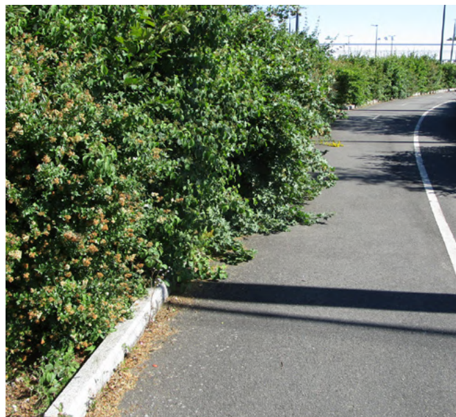
Plantations débordant sur le cheminement des piétons ou sur des pistes cyclables. Des interventions régulières de taille sont à réaliser pour dégager les voies (type de taille qui n'est pas toujours adapté au mode de développement des espèces). / Pierre Héry
