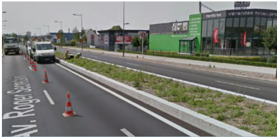
TPC végétalisé nécessitant la neutralisation d'une voie avec balisage important lors des opérations d'entretien ce qui impacte la circulation./ Google Street
