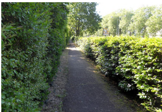
Trottoir coincé entre 2 haies taillées nécessitant un entretien trop soutenu. / Pierre Héry
