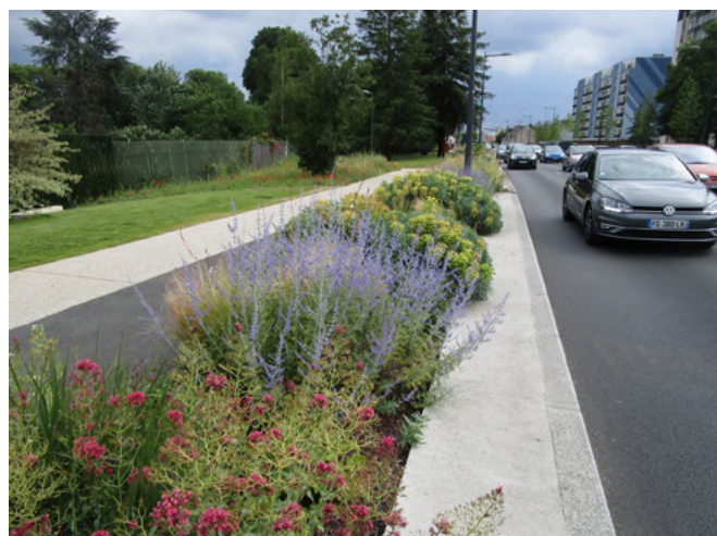
Bande « passe-pied » mise en place entre le massif planté et la route. L'entretien est simplifié grâce à l'éloignement des végétaux de la voie et le scellement des bordures. / Pierre Héry
