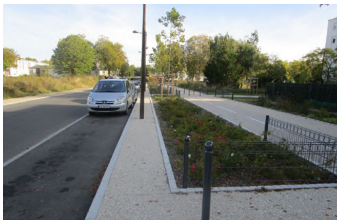
Initialement dans le projet de conception, le massif venait au raz du stationnement. Les services techniques de la collectivité ont demandé la mise en place d'une zone passe-pied permettant aux usagers d'accéder à leur véhicule./ Pierre Héry
