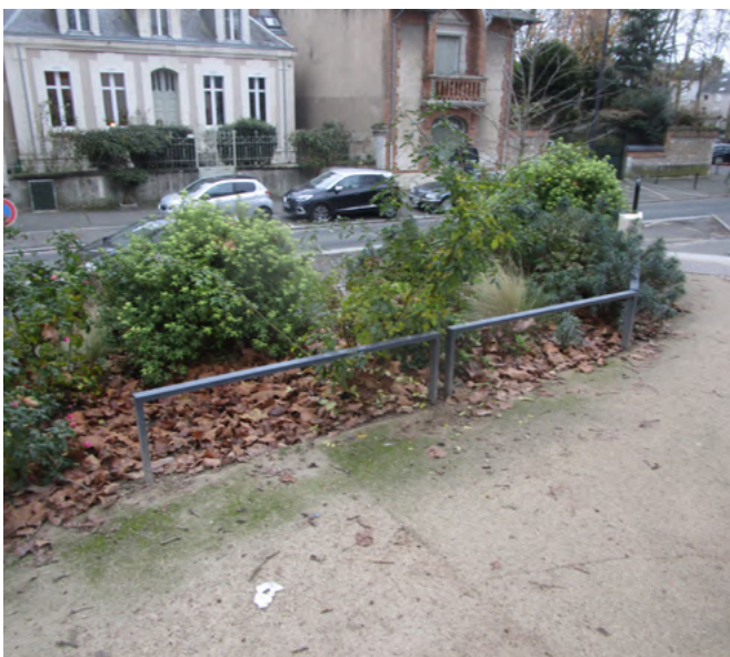
Lisse métallique protégeant le massif du piétinement./ Pierre Héry
